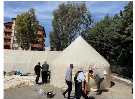
内側から空気を送りテントを膨らませる
